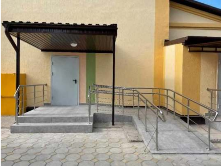
Фасад учебного корпуса после капитального ремонта. Новый облик.
